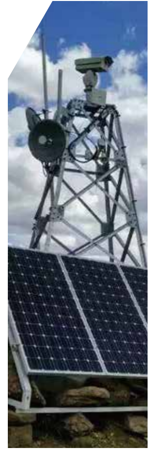
Perimeter Neimenggu China
